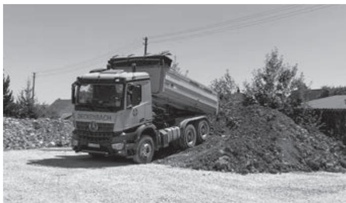
Die Bauarbeiten zur Verlegung des Glasfasernetzes durch die Fa. Deckenbach haben planmäßig begonnen. Aus Richtung Suppingen werden Kabel durch die Ortslage von Berghülen und Bühlenhausen verlegt. Der Bodenaushub muss regelmäßig beprobt werden, bevor dieser auf einer Deponie abgelagert werden kann. Daher wird das Material auf dem Gemeindegrundstück im Fasanenweg zwischengelagert, bis die Beprobung durchgeführt ist.
